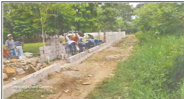
Foto 2: TRABAJADORES INICIANDO CON EL MURO PERIMETRAL.
