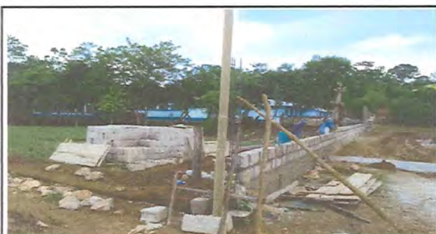
Foto 3: MATERIALES Y COMIENZO DEL MURO PERIMETRAL.
