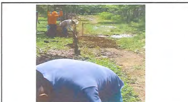
Foto 4: ZANJAMIENTO PARA PREVIO AL COMIENZO DEL TRABAJO DE PERIMETRACION.
