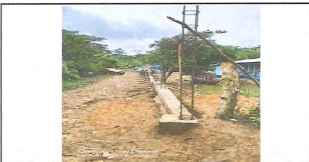
Foto 5: VISTA DEL PROCESO DE AVANCE PREVIO AL ZANJAMIENTO QUE SE REALIZO.
