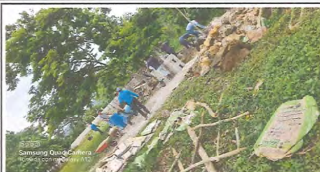
Foto1: VISTA PREVIA EN LA PARTE DE ADENTRO, YA AVANZANDO CON EL MURO PERIMETRAL.
