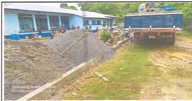
Foto:6 LLEGADA DE MATERIALES BLOCK, ARENA, PIEDRA.
